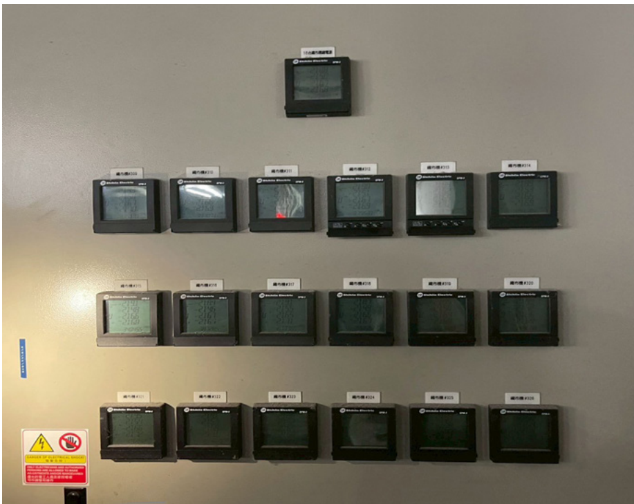
圖四十三 以 IoT 設備監控廠內能耗，協助擬定設備汰換計畫
